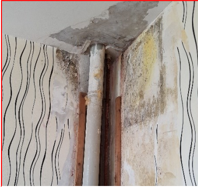
Foto 3-4: Schimmel in de leidingkast
