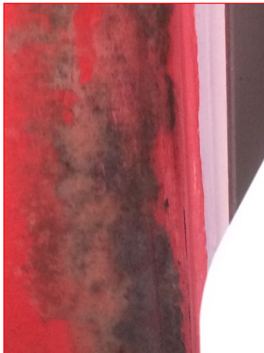
Foto 1-1: Schimmelvorming komt door het behang heen
