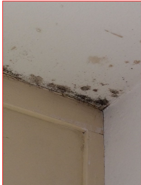
Foto 3-3: Uitgebreide schimmelvorming aan het plafond in de huiskamer
